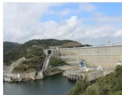
A Barragem de Alqueva tem capacidade para bombear cerca de 42 m<sup>3</sup>/s de água.
